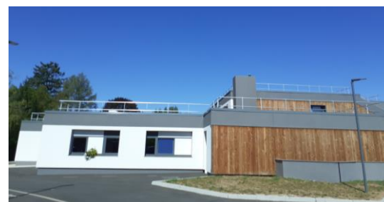
La maison France Services de Meung-sur-Loire, réhabilitation en matériaux bio-sourcés.
